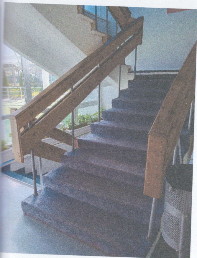
Лестница внутри здания (3.3)
